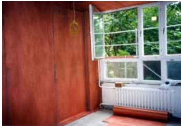
Einbau einer Schirmtapete
